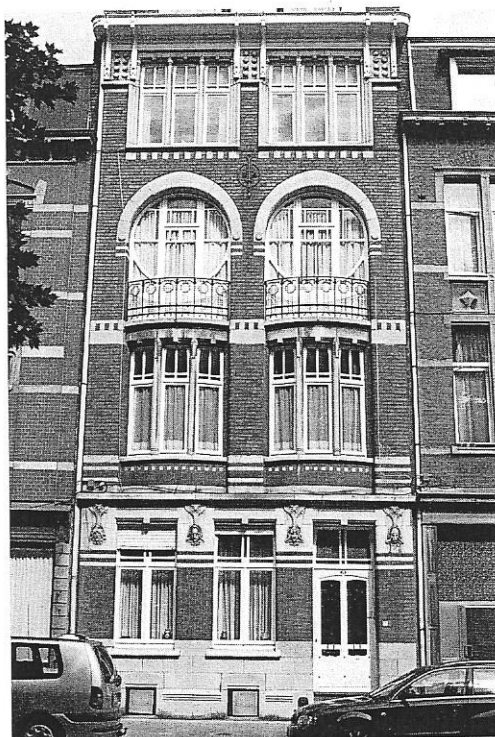
Joseph Barsin, maison Alexandre, Liège, rue Ernest de Bavière, 1907.
