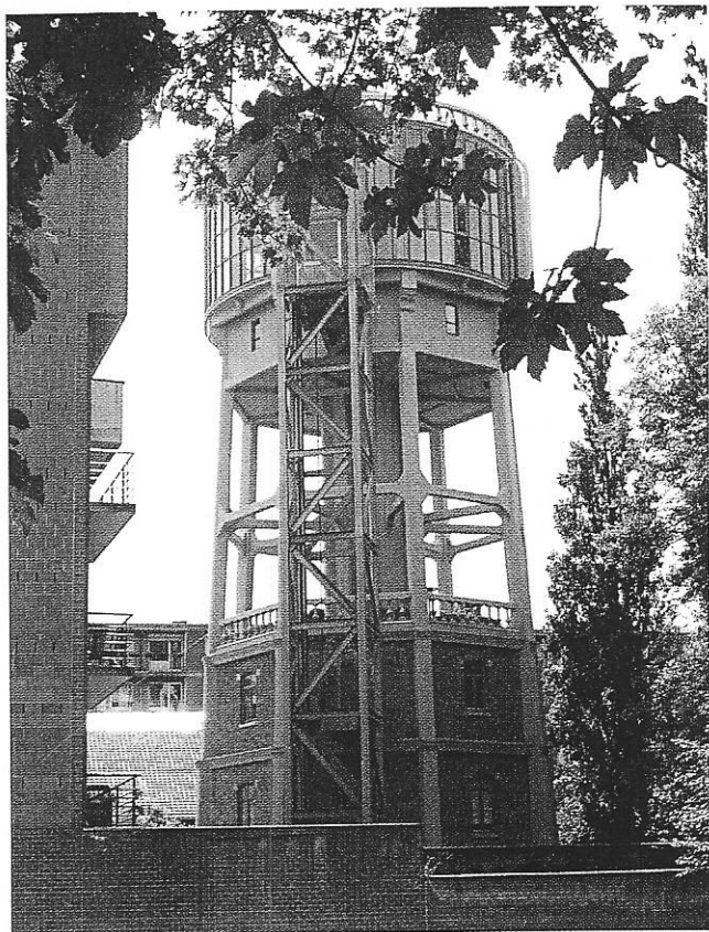
Château d'eau de la rue Marconi à Forest, construit en 1904. Capacité 500 m 3 . Photo de l'auteur.
