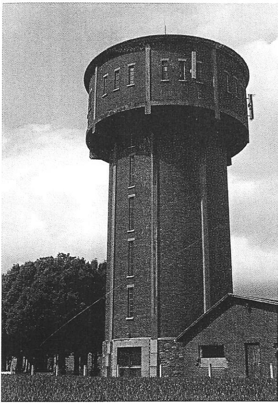
Château d'eau à Emines de type «lanterne» avec parement en pierre naturelle et en brique, 1960. Capacité 500 m 3 . Photo de l'auteur.
