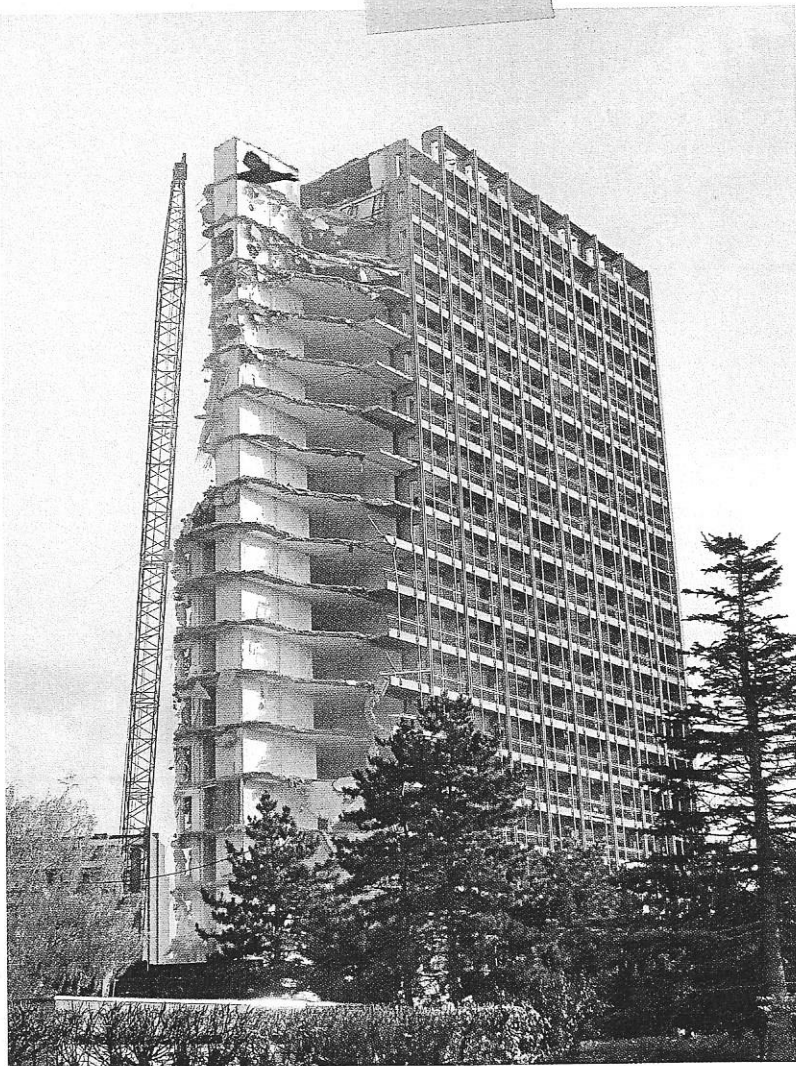
Démolition d'une des tours de Droixhe. © Bureau Quadra
